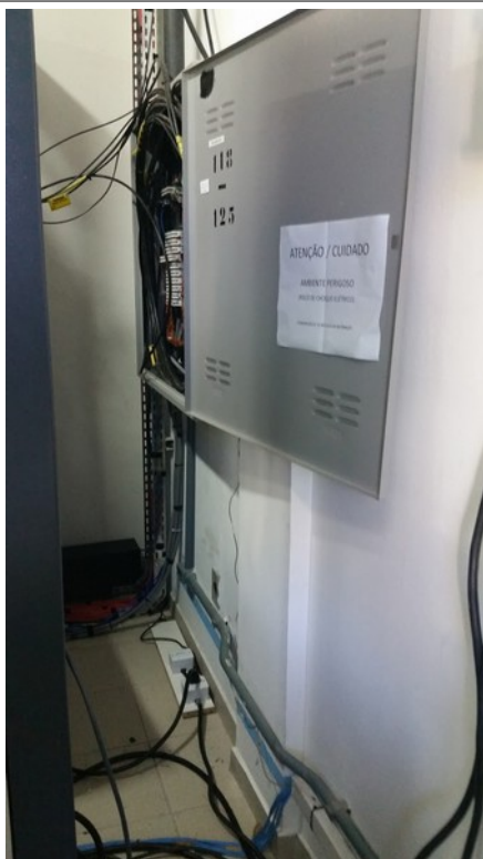
Figura 6.17.5 Painéis e fiações acessíveis inadequadamente
