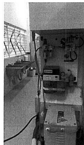
Figura 6.3.6: Detalhe maquinário e cubas
