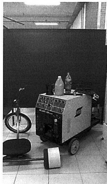
Figura 6.4.6: Equipamentos e materiais soldagem
